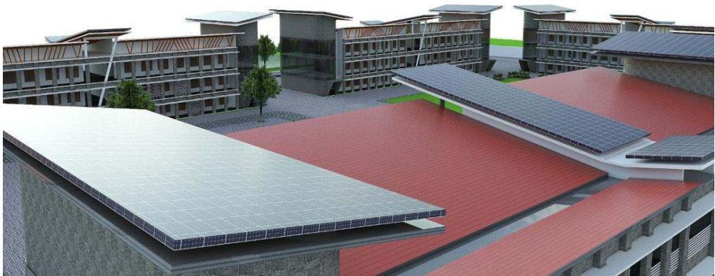
Gambar 3.10. Desain Atap Gedung SMK Dilengkapi Panel
